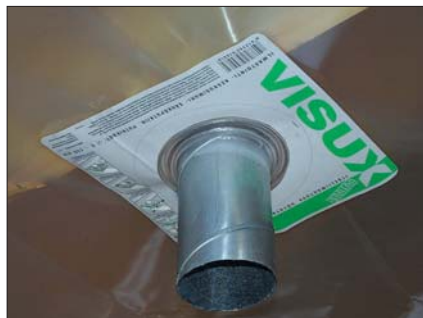
Ilmastointiputken juuri tiivistämisen jälkeen.
