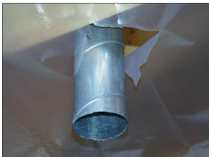
Ilmastointiputken juuri ennen tiivistämistä.
