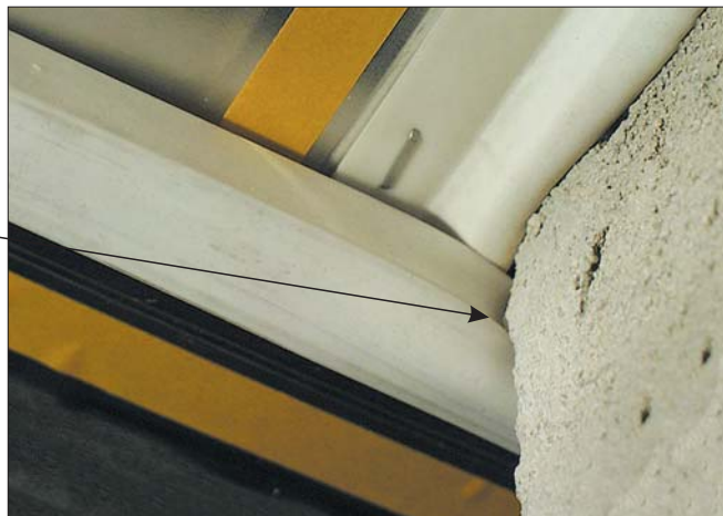
Tiiviste muotoutuu hyvin rappausta vasten
